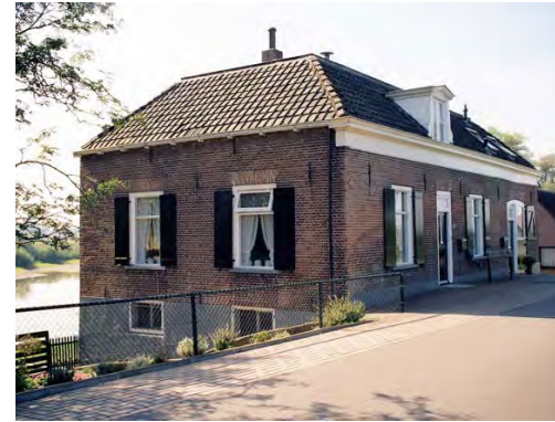
Opbouw op de taludrand van de IJsseldijk
