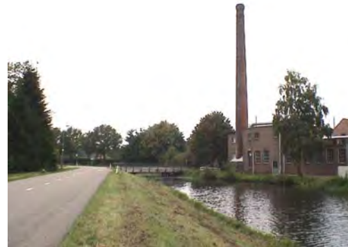
Kloosterbrug bij de Kloosterweg/Kanaaldijk
