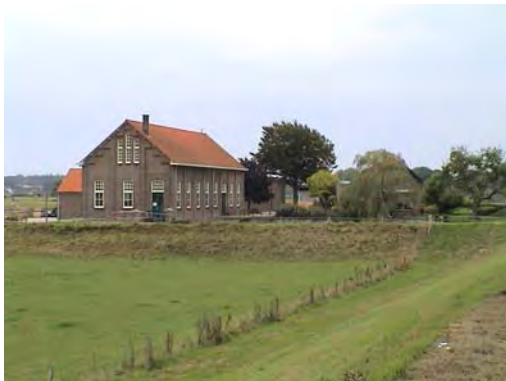
Gemaal Veluwe bij de Weverdijk
